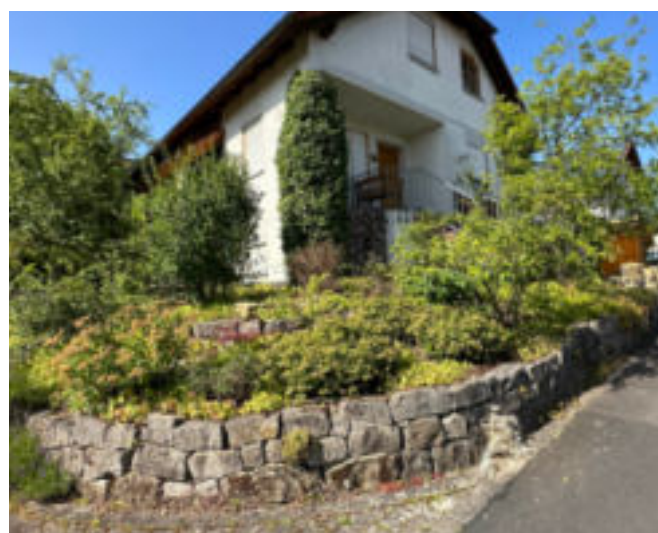
In verschiedenen Quartieren Eisingens wurde lediglich ein Zaunsockel errichtet und auf eine Einfriedung verzichtet.
