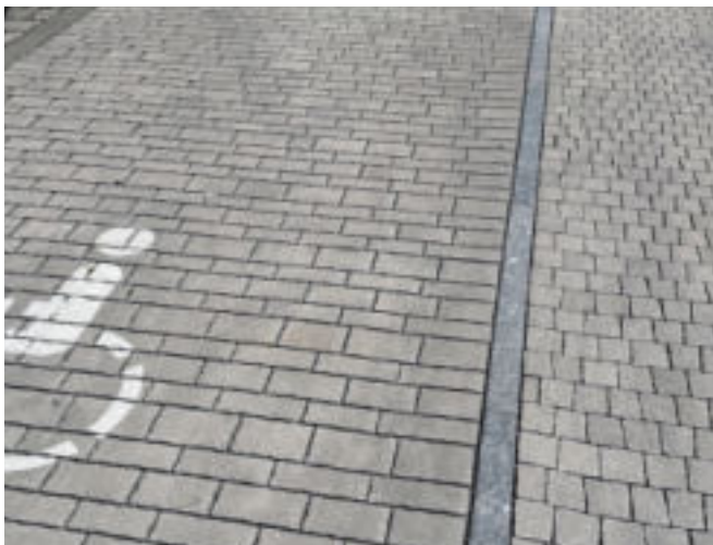
Betonpflaster im öffentlichen Raum
