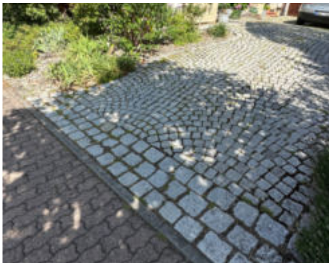
Betonpflaster im öffentlichen Raum, Granitpflaster in der privaten Einfahrt
