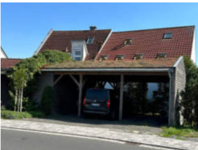
Begrünter Carport in Gerbrunn
