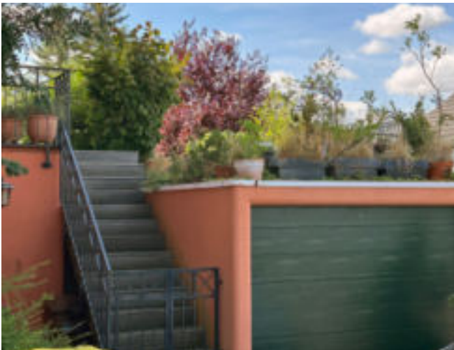
Alternative Nutzung des Garagendaches als Terrasse. Auch so kann versiegelte Fläche gespart werden.
