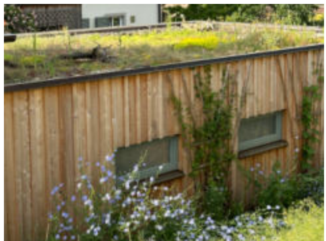
Begrünung einer Garage in Gerbrunn
