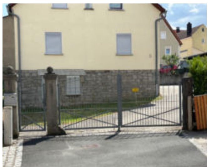
Historische Pfeiler mit Metalltoren.
