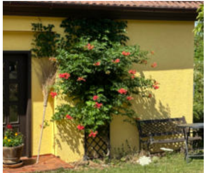
Fassadenbegrünung am Rankgerüst mit einer Trompetenblume.
